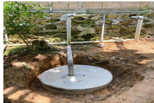
Gambar 4. Hasil dari Pembuatan SPAL
