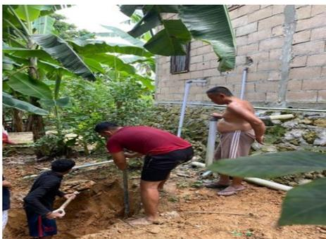
Gambar 3. Proses Pembuatan SPAL
